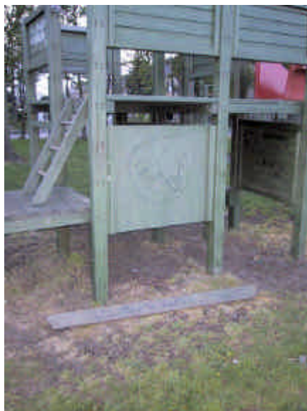
Losse plank aan speeltoestel met glijbaan: te herstellen Ketting van zitje van schommel op één punt gebroken: te herstellen
