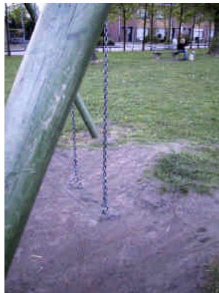
Losse plank aan speeltoestel met glijbaan: te herstellen Ketting van zitje van schommel op één punt gebroken: te herstellen
